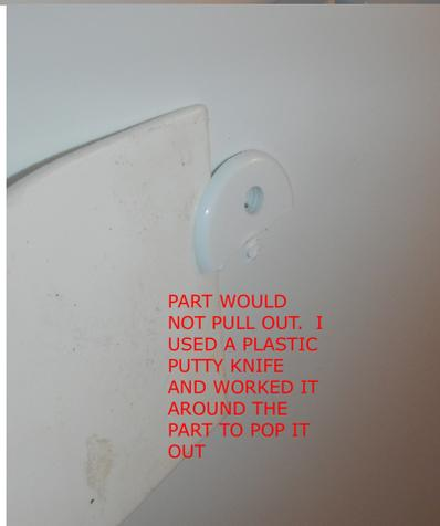
PART WOULD NOT PULL OUT. I USED A PLASTIC PUTTY KNIFE AND WORKED IT AROUND THE PART TO POP IT OUT
